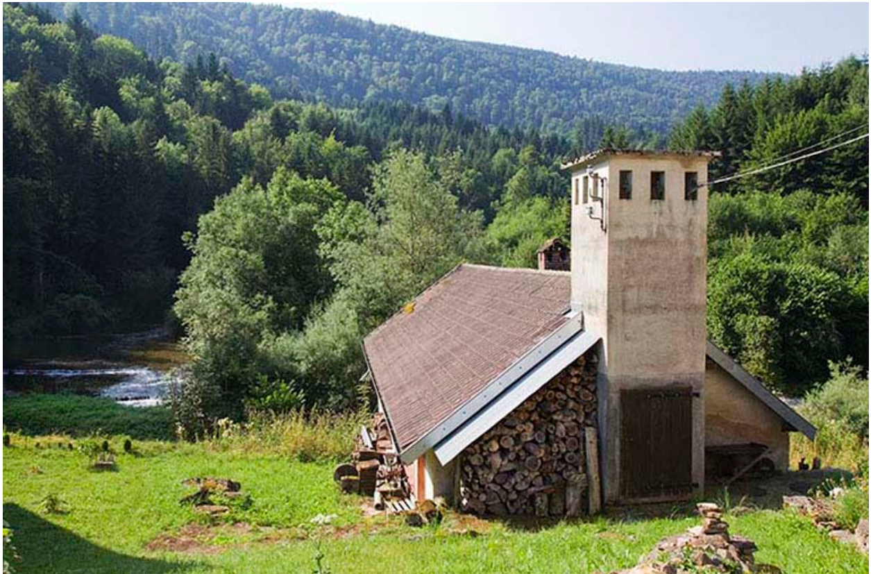
Centrale : façade latérale droite et transformateur.
