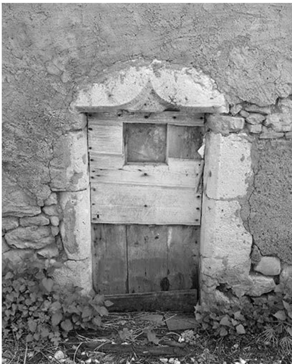
Linteau en accolade sur la façade postérieure.
