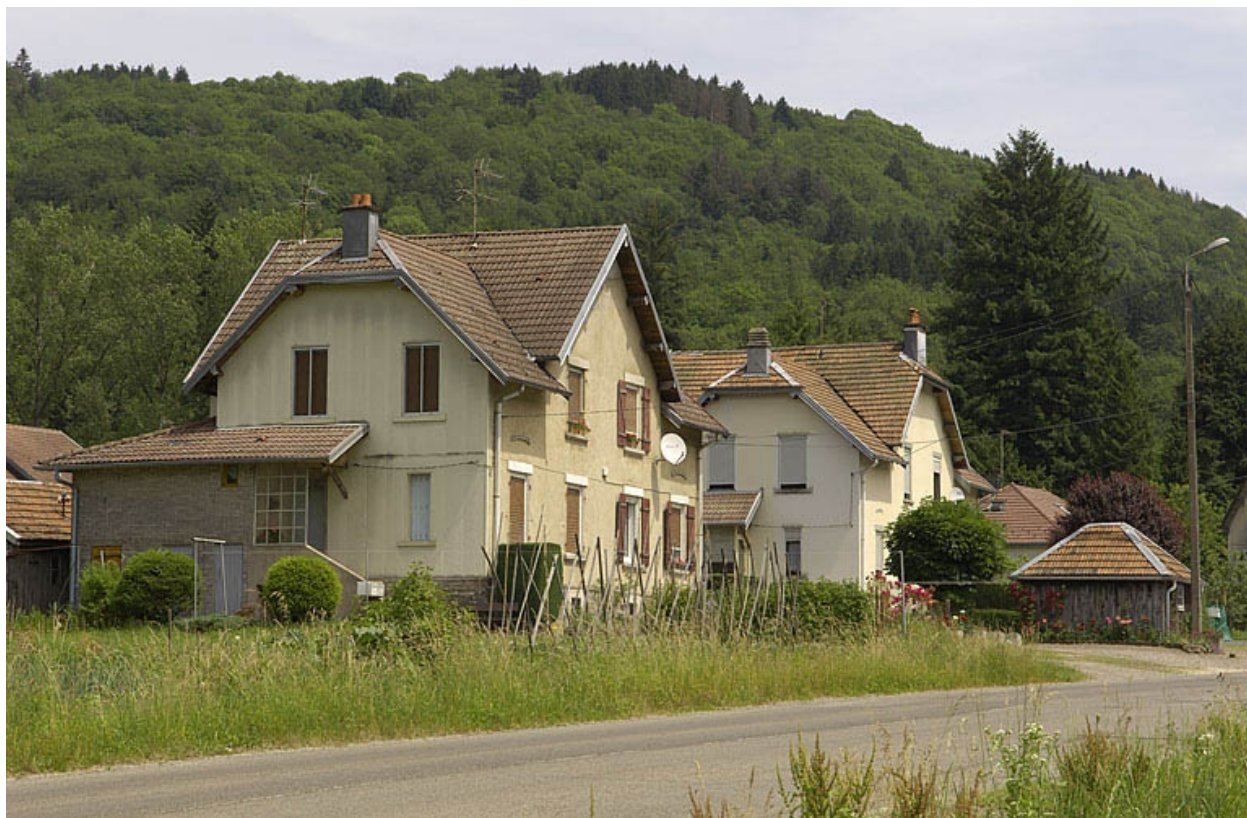
Vue d'ensemble des logements de contremaître.
