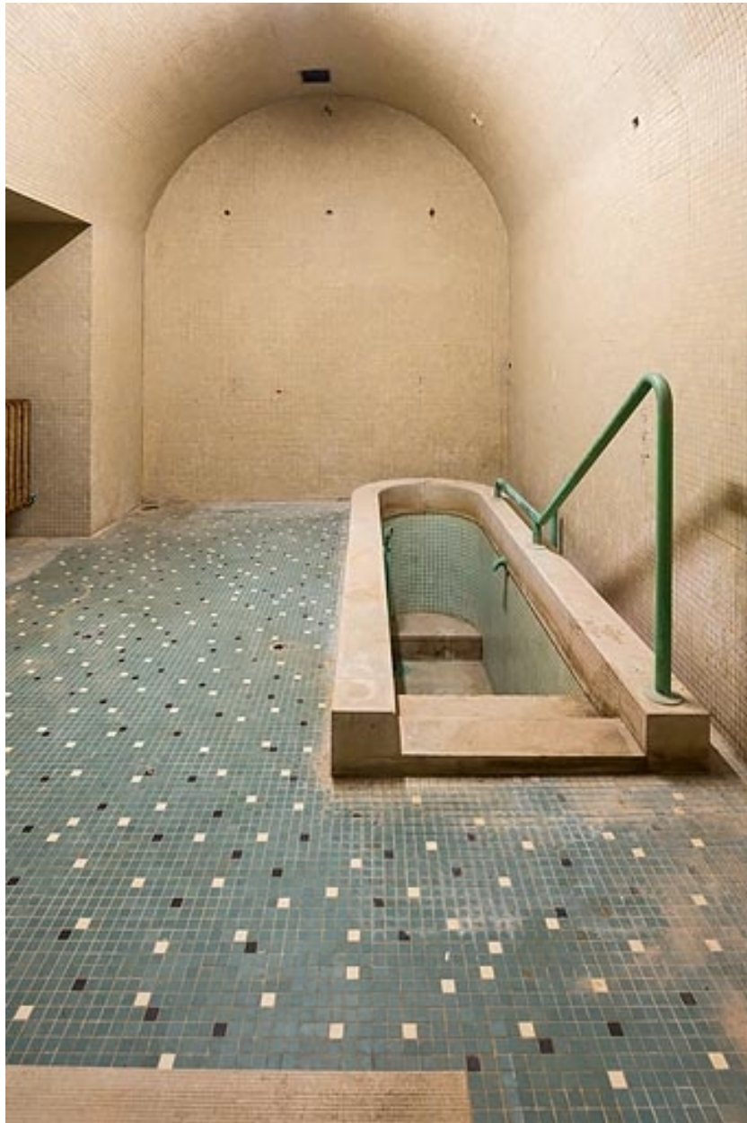
Ancienne cabine de bain, au rez-de-chaussée.
