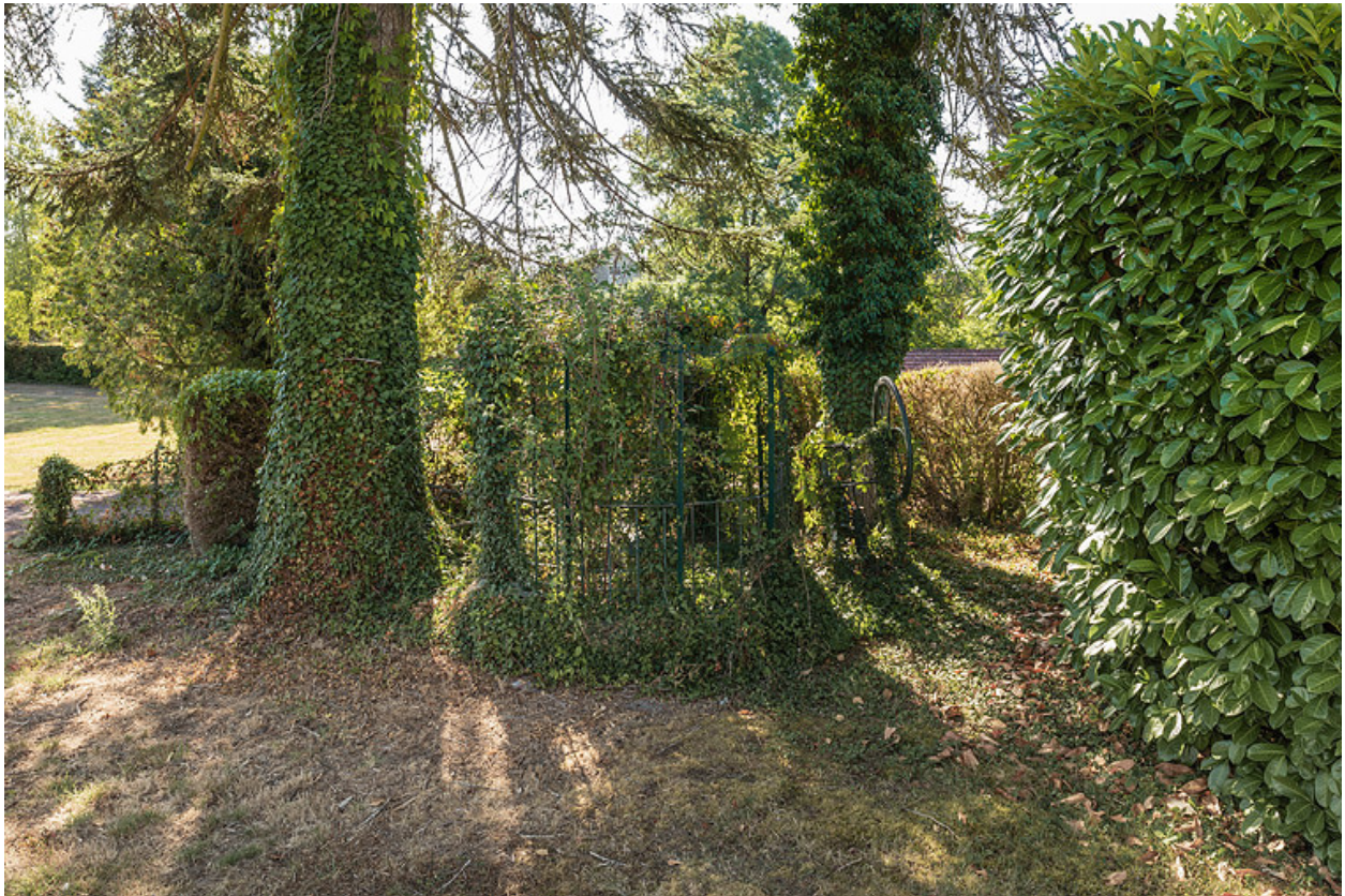
Ancienne pompe à eau, envahie par la végétation.
