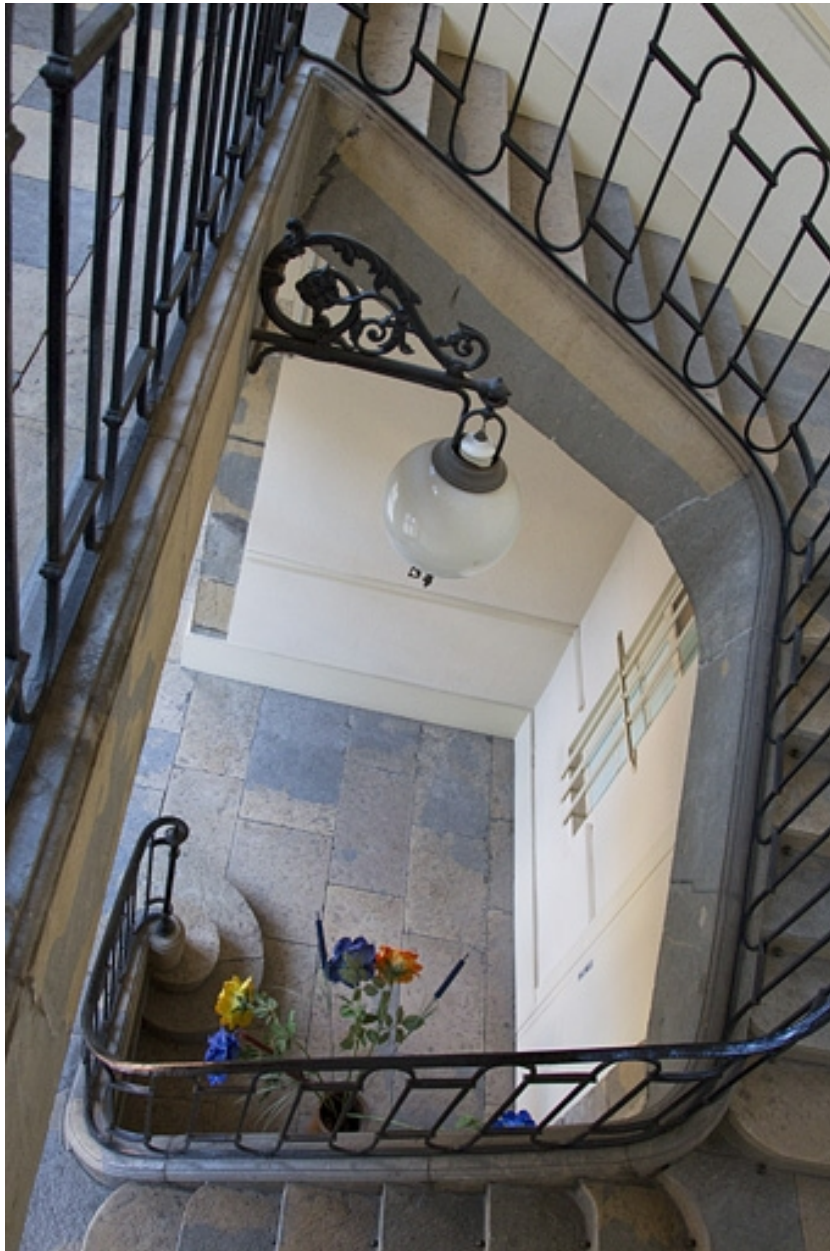
Intérieur, escalier d'honneur : vue en plongée.
