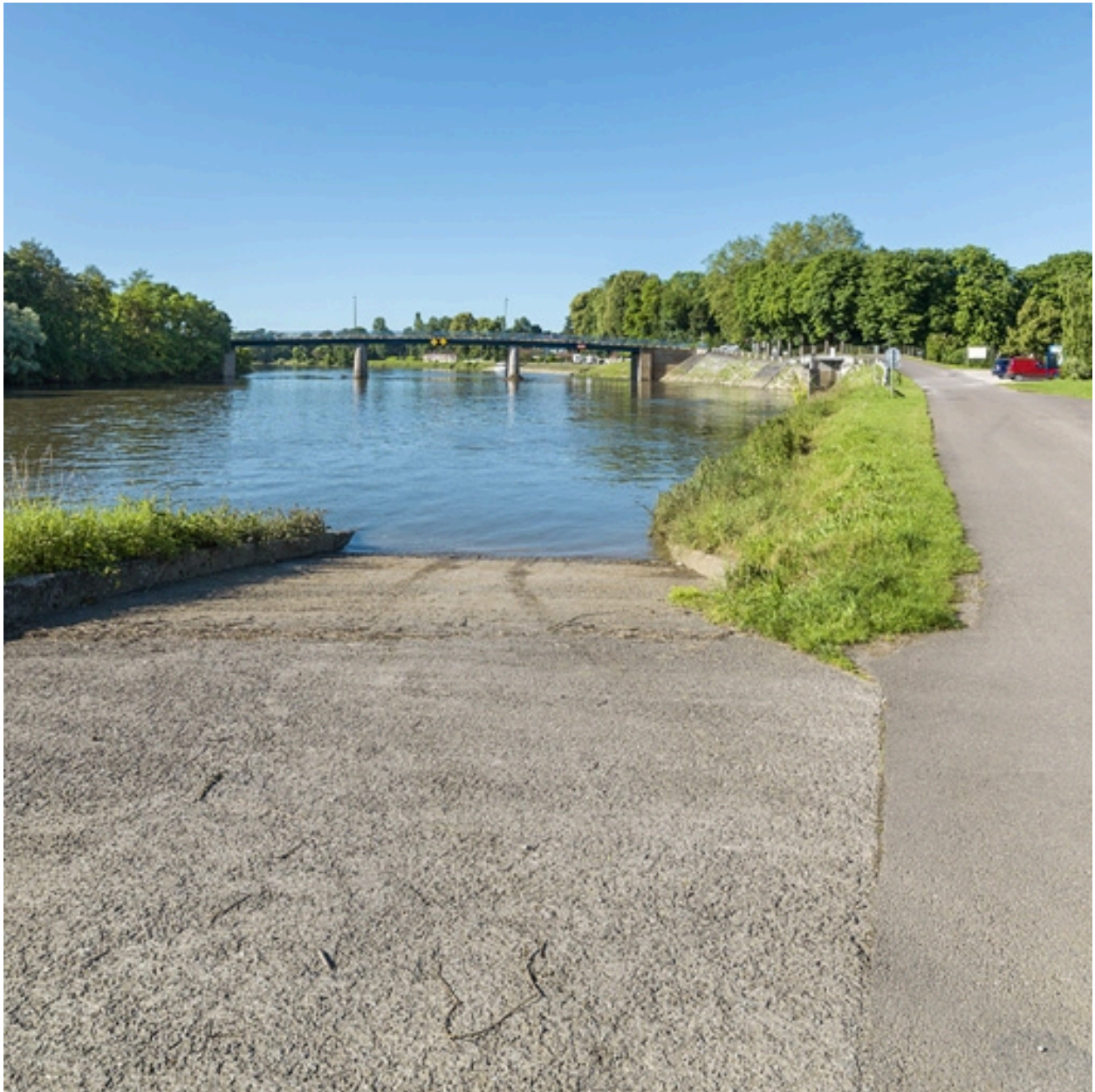
Vue d'ensemble depuis la rampe de mise à l'eau, rive droite.
