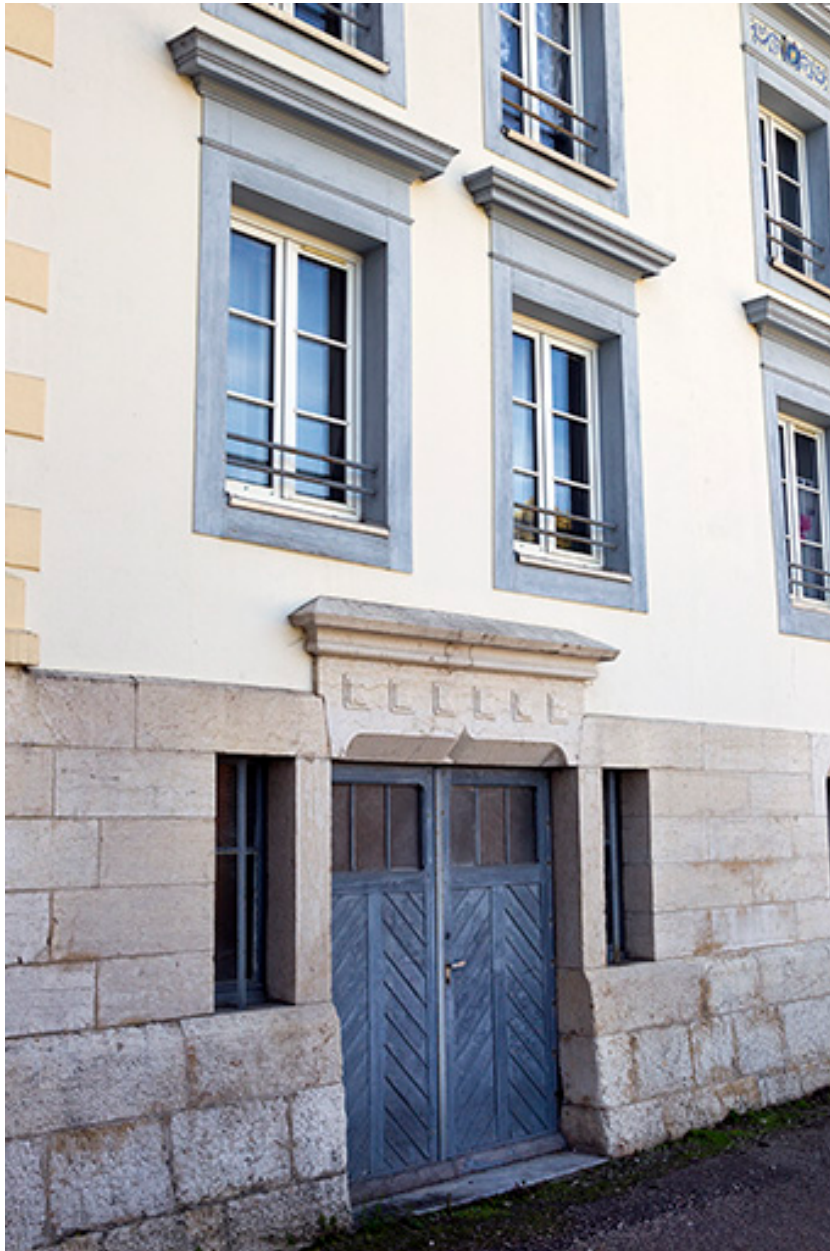
Premier atelier de fabrication, façade latérale gauche : porte au rez-de-chaussée.
