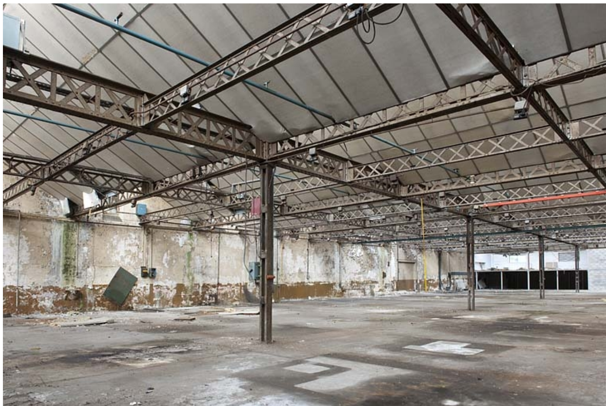
Atelier de fabrication. Vue depuis le nord-ouest.
