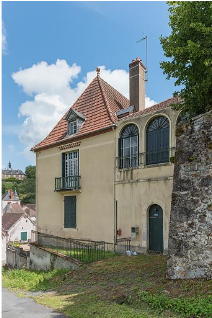
Vue depuis la rue de La Roche.
