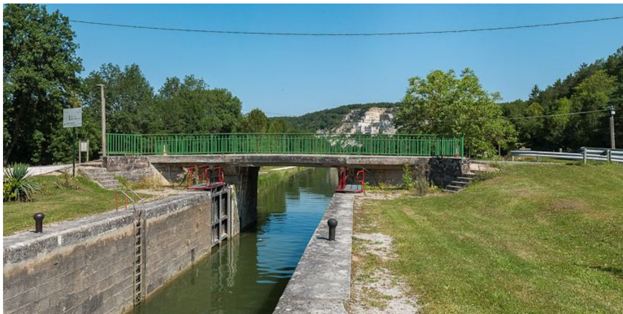
Le pont vu du sas.
