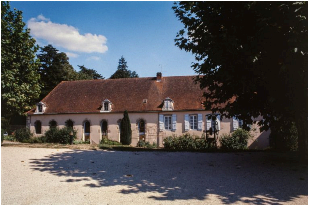
Vue générale de l'ancien hôpital, façade postérieure.
