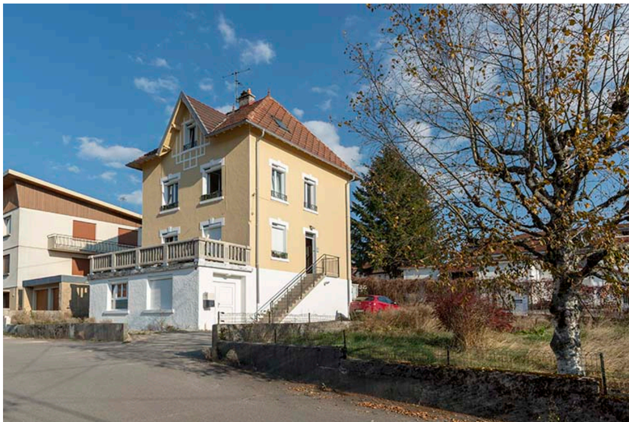
Façades antérieure et latérale droite.
