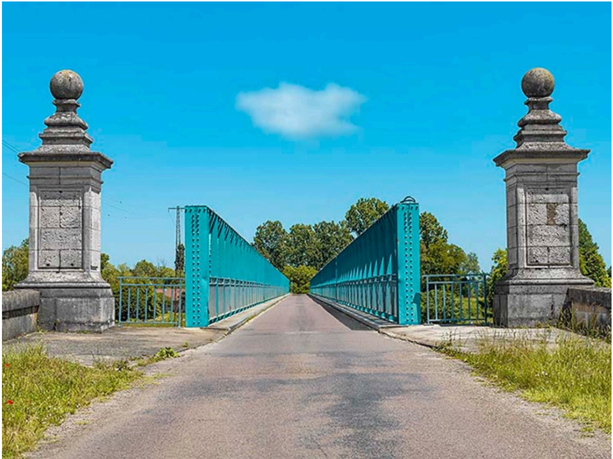
Entrée du pont.
