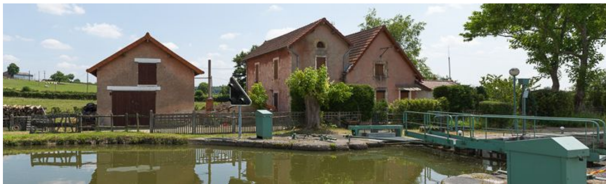
Vue d'ensemble du site atypique.
