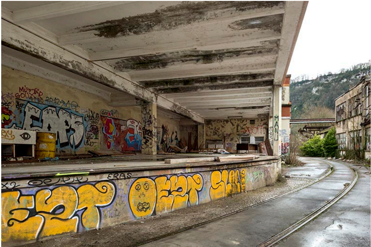
Etat en 2016. Usine A : quai à l'extrémité sud-ouest de l'étirage tergal.
