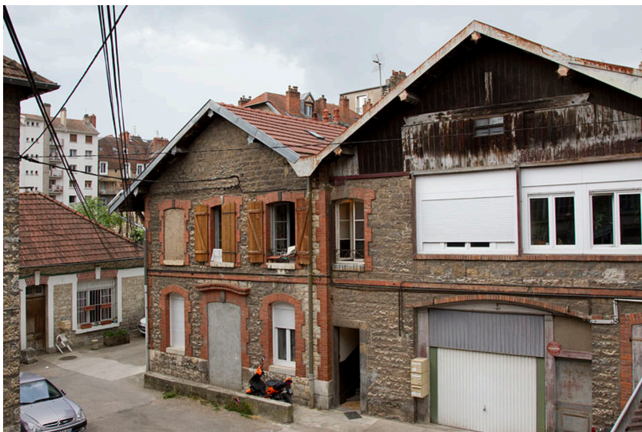
Pignons ouest de la distillerie.
