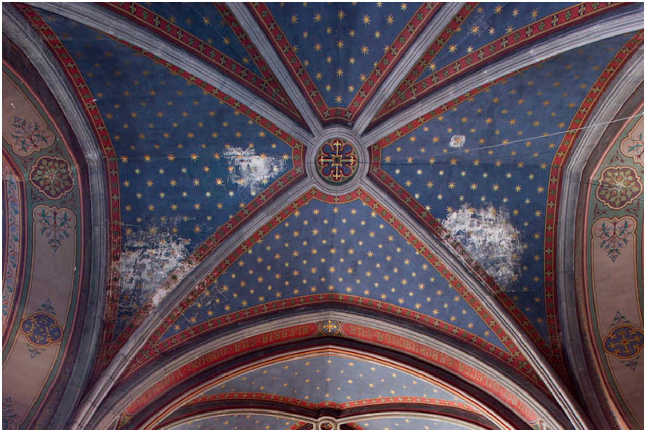
Voûte d'ogives située couvrant le chœur de la chapelle.
