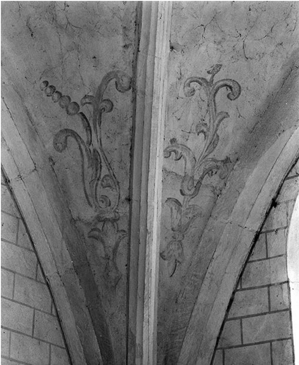
Voûte du choeur : décor peint (angle postérieur droit).
