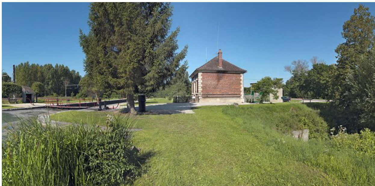
Maison éclusière : côté droit.
