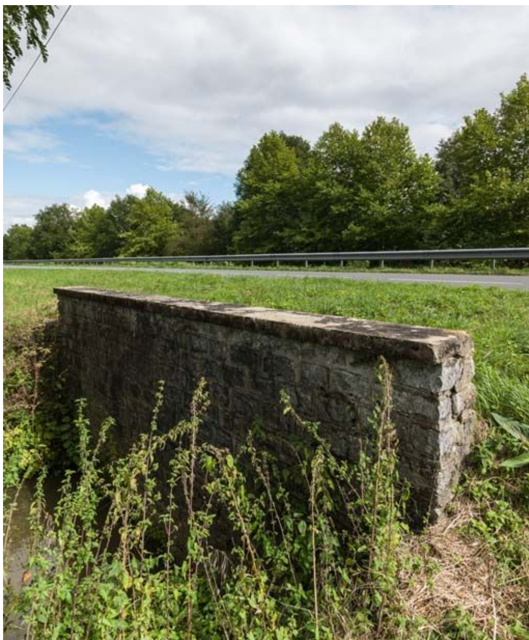
Vue de l'aqueduc.
