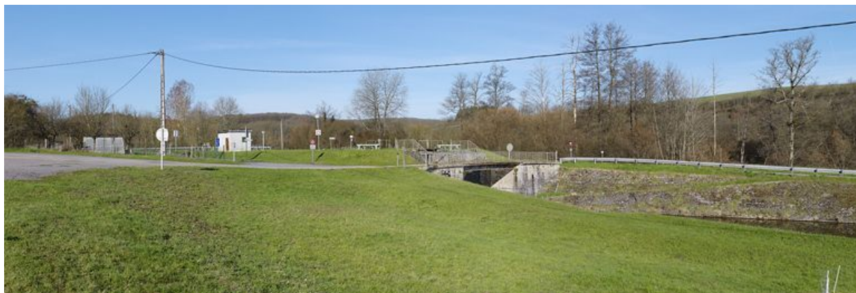
Vue d'ensemble du site d'écluse.
