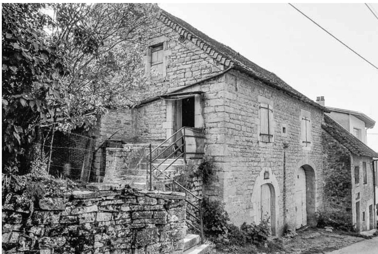
Ferme située rue du Meix Dagay : vue d'ensemble.
