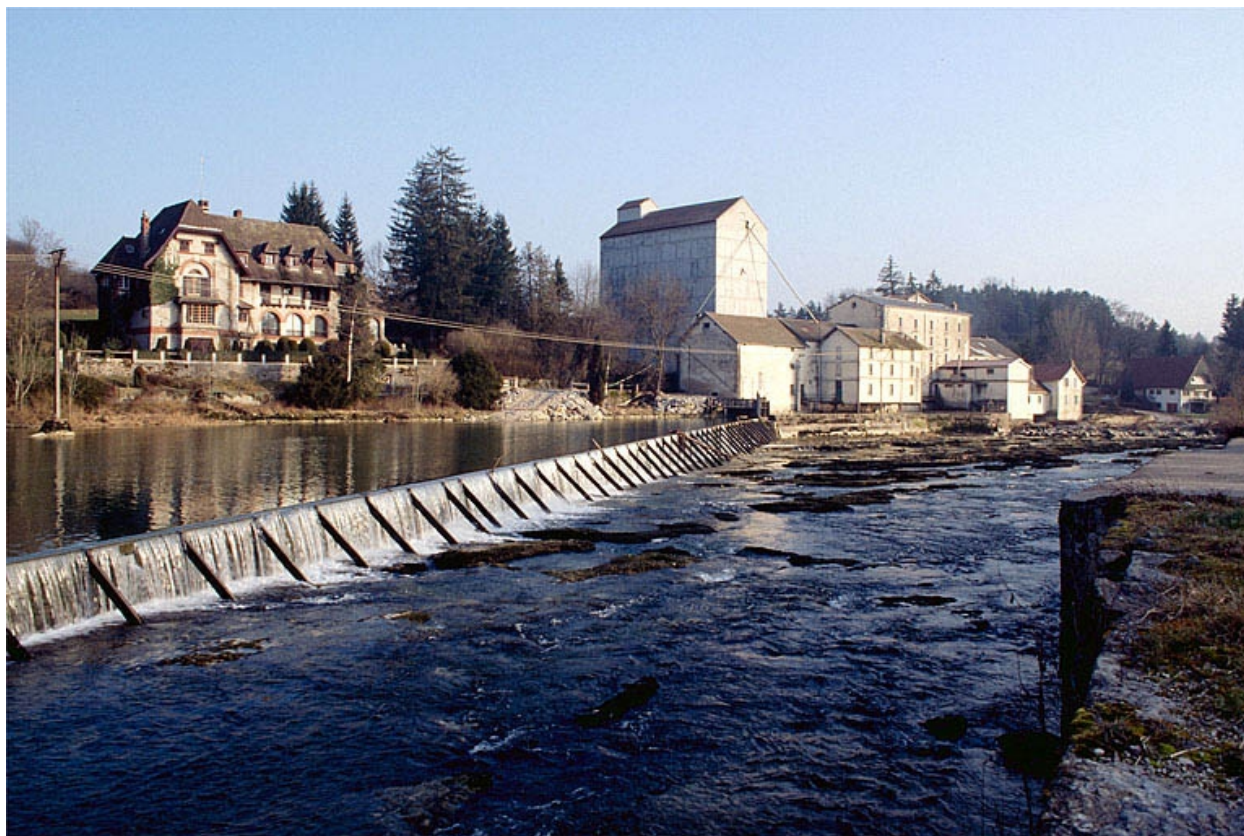
Logement patronal et minoterie depuis l'ouest. Au premier plan : barrage sur l'Ain.
