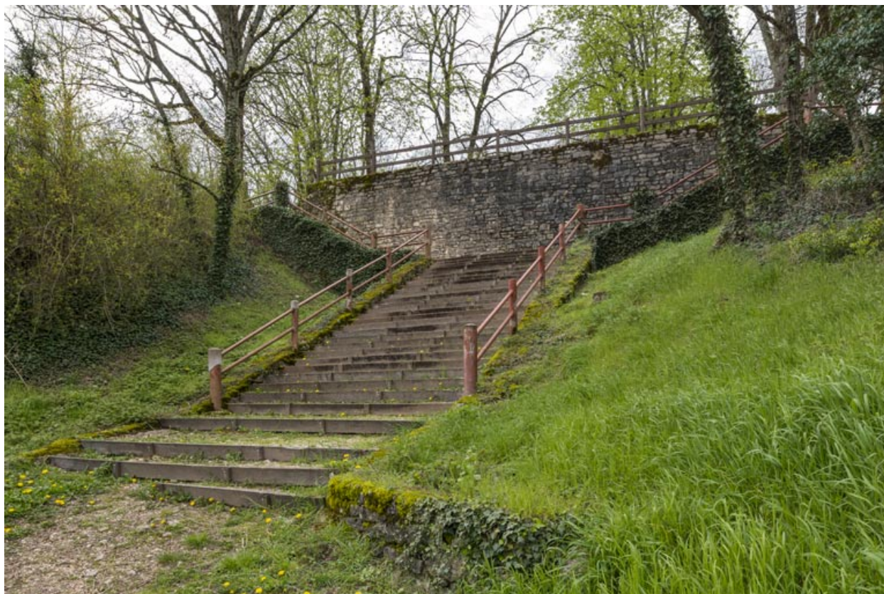
Escalier et mur de soutènement.
