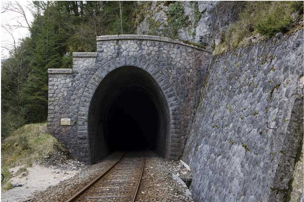
Tunnel : tête côté Andelot-en-Montagne (nord).
