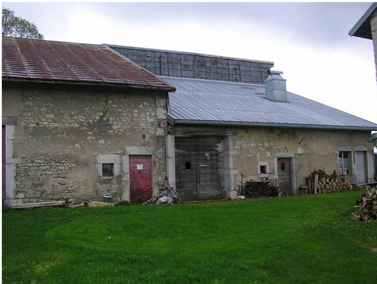
Ferme située au lieu-dit Le Coin d'Aval.
