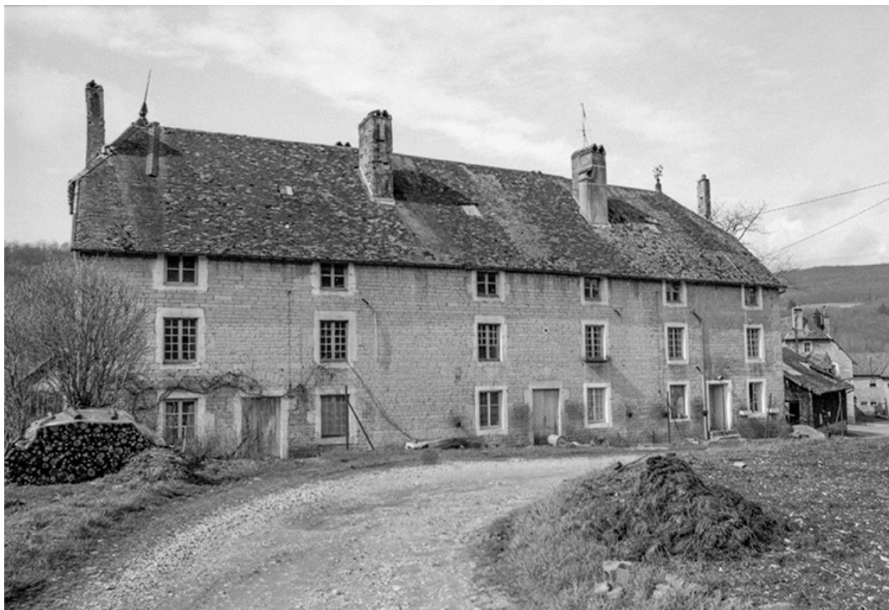
Logement ouvrier. Façade antérieure (est) en 1979.
