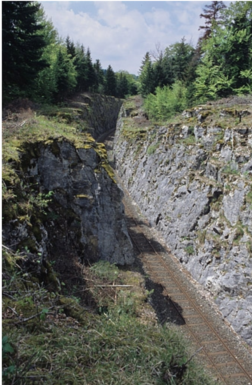
Tranchée côté Andelot-en-Montagne, vue du pont.
