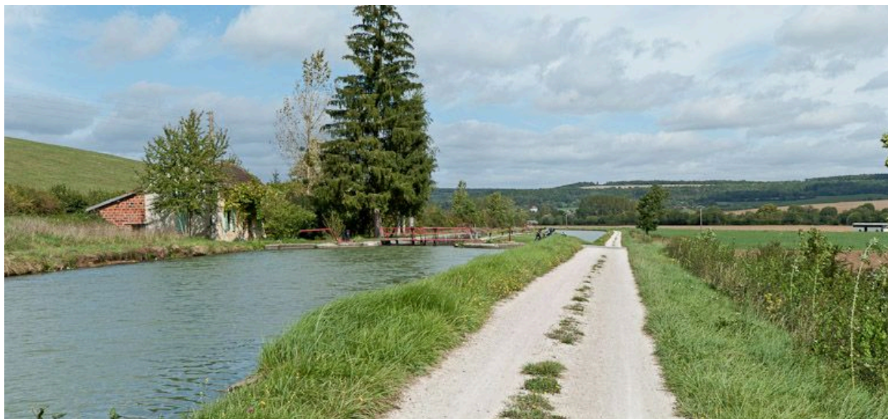
Vue du site d'écluse depuis l'amont.
