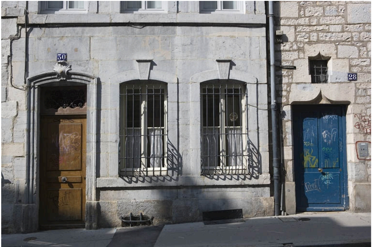
Détail du rez-de-chaussée de la façade sur rue, de face.
