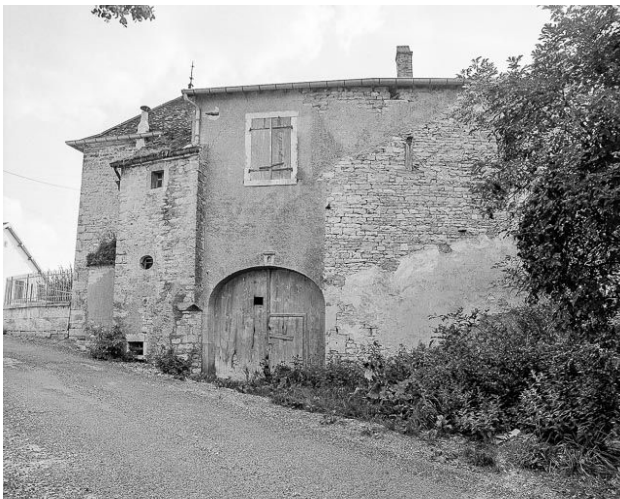
Vue rapprochée de la façade latérale droite.
