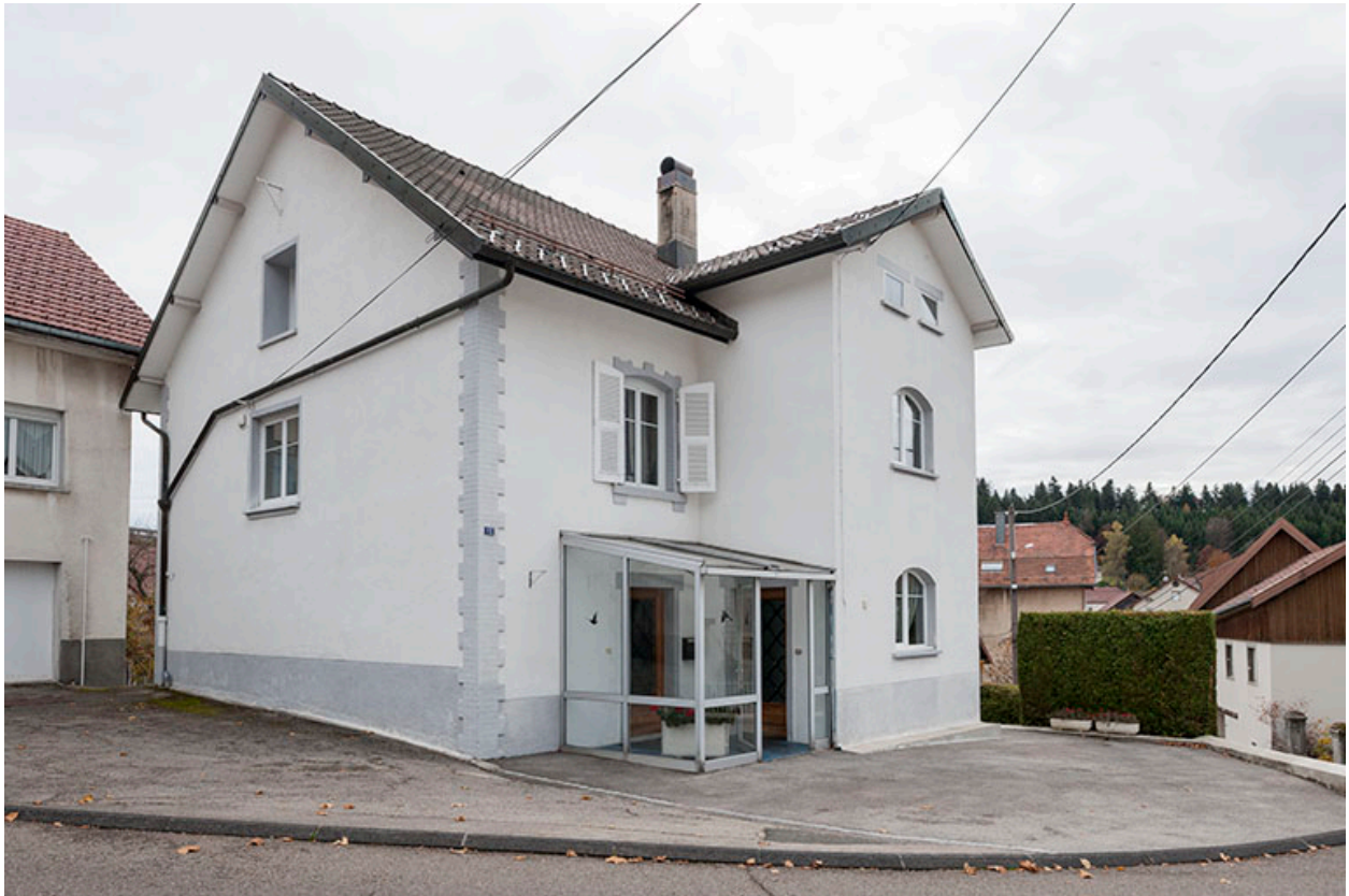
Façades antérieure et latérale gauche.
