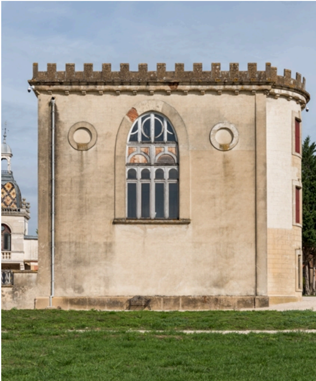
Elévation latérale droite (corps sud).
