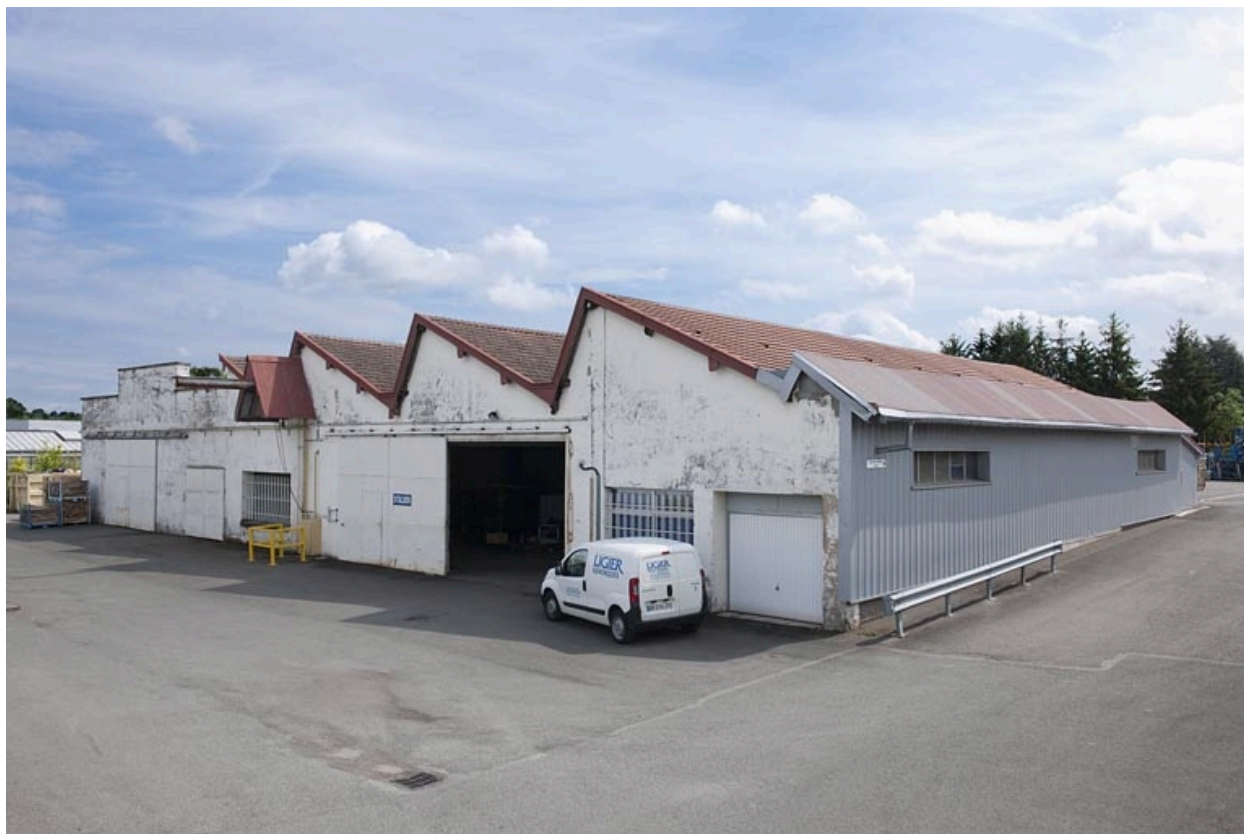
Atelier de fabrication ouest.
