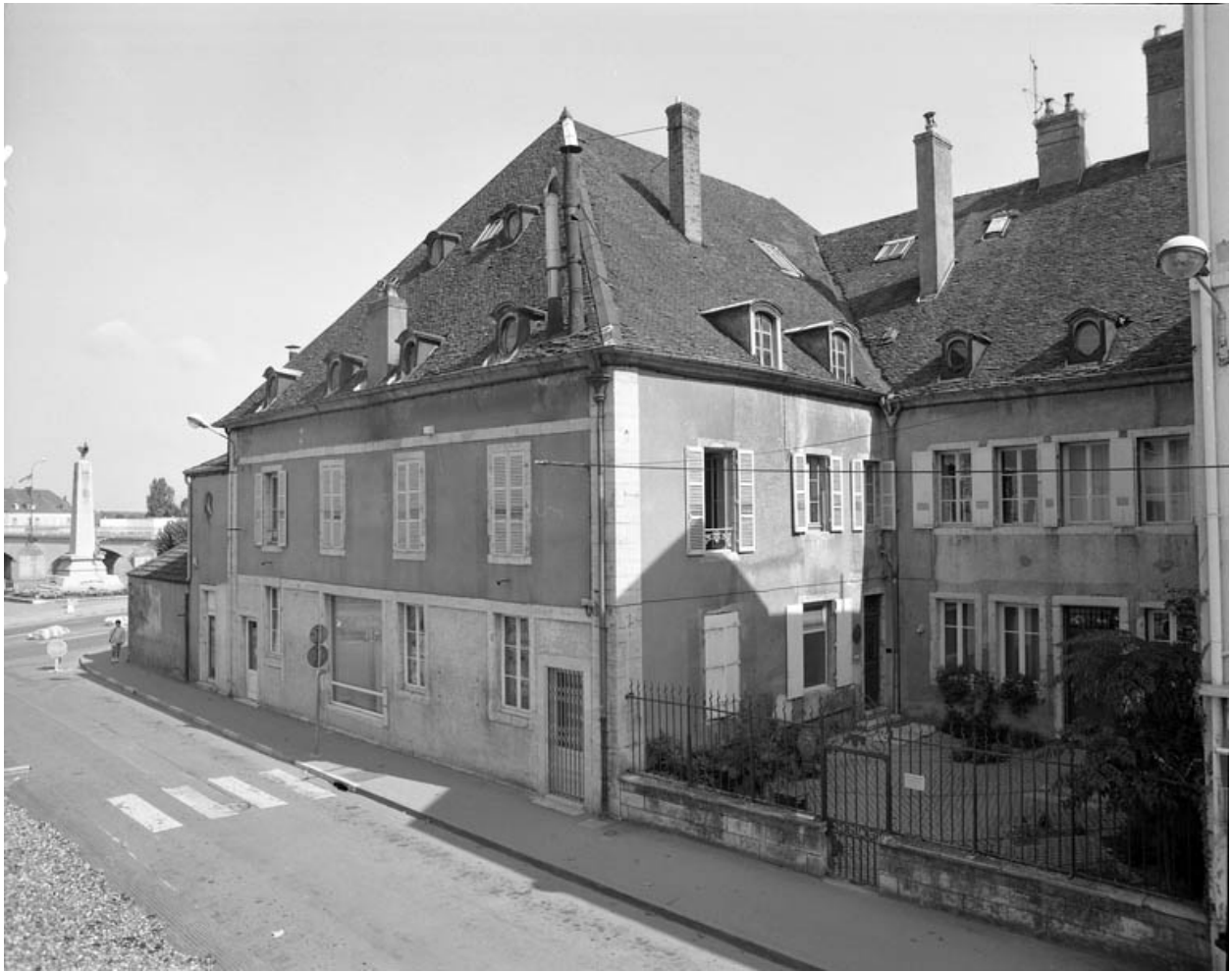
Façade latérale droite de trois quarts droit, avant restauration.
