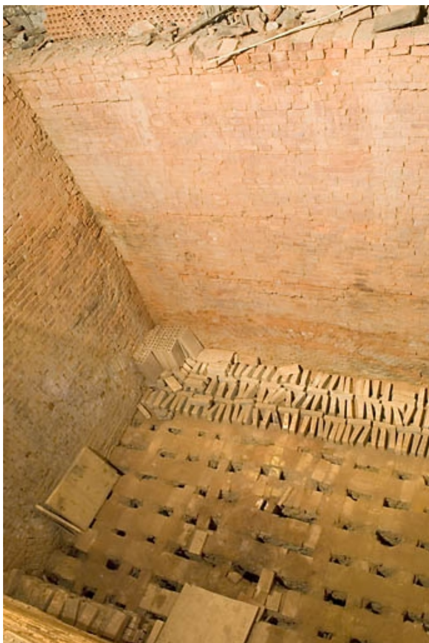
Vue plongeante à l'intérieur du four.
