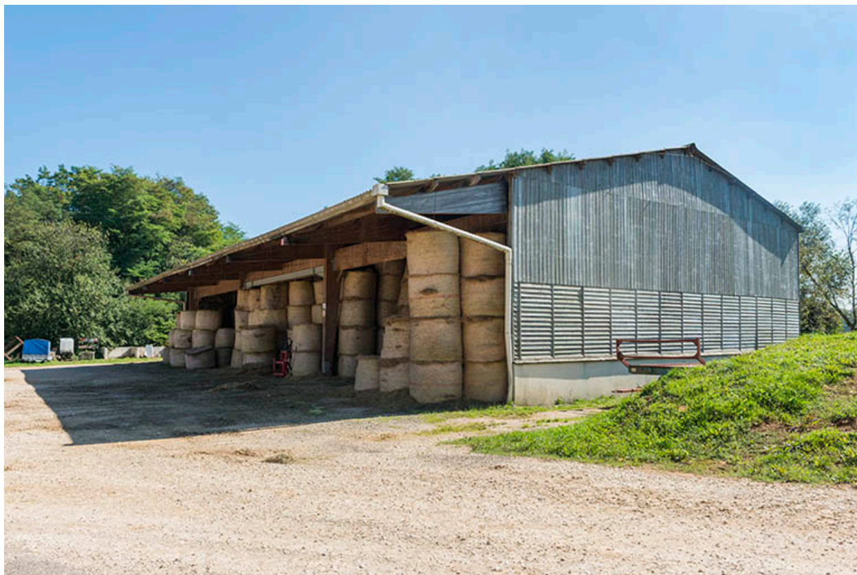
Angle ouest du hangar à fourrage sud-est.
