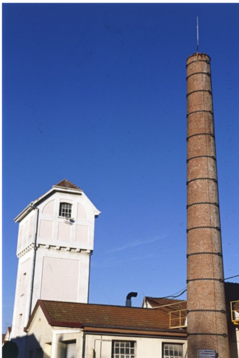
Réservoir industriel et cheminée depuis le sud-ouest.
