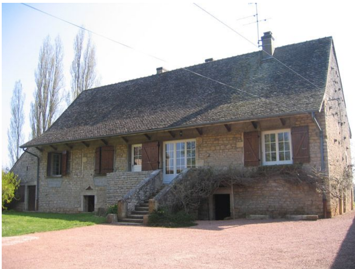
Vue d'ensemble de la façade.
