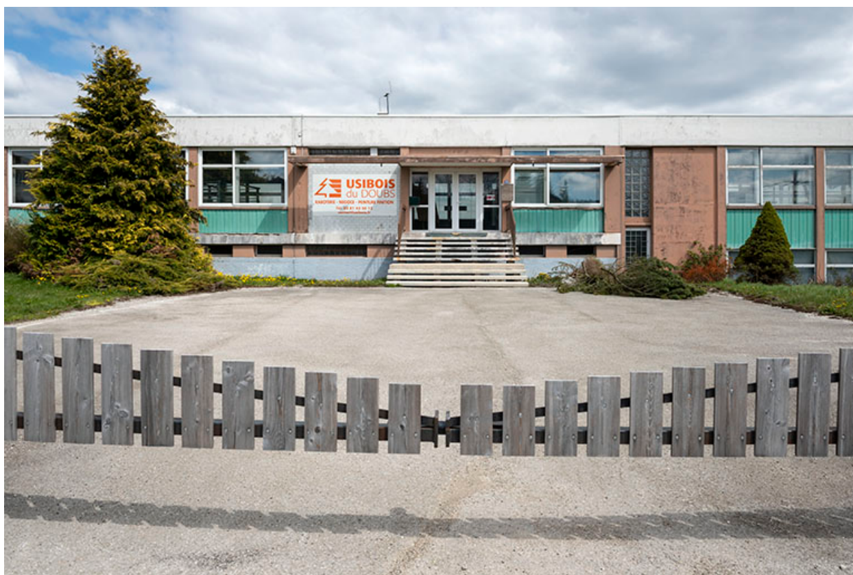
Façade antérieure : entrée.
