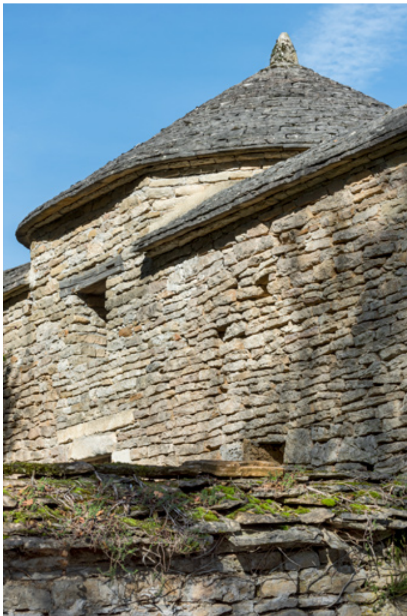
Rempart entrée ouest.
