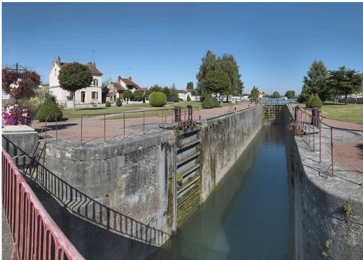
Site d'écluse vu d'amont : portes et bajoyers.
