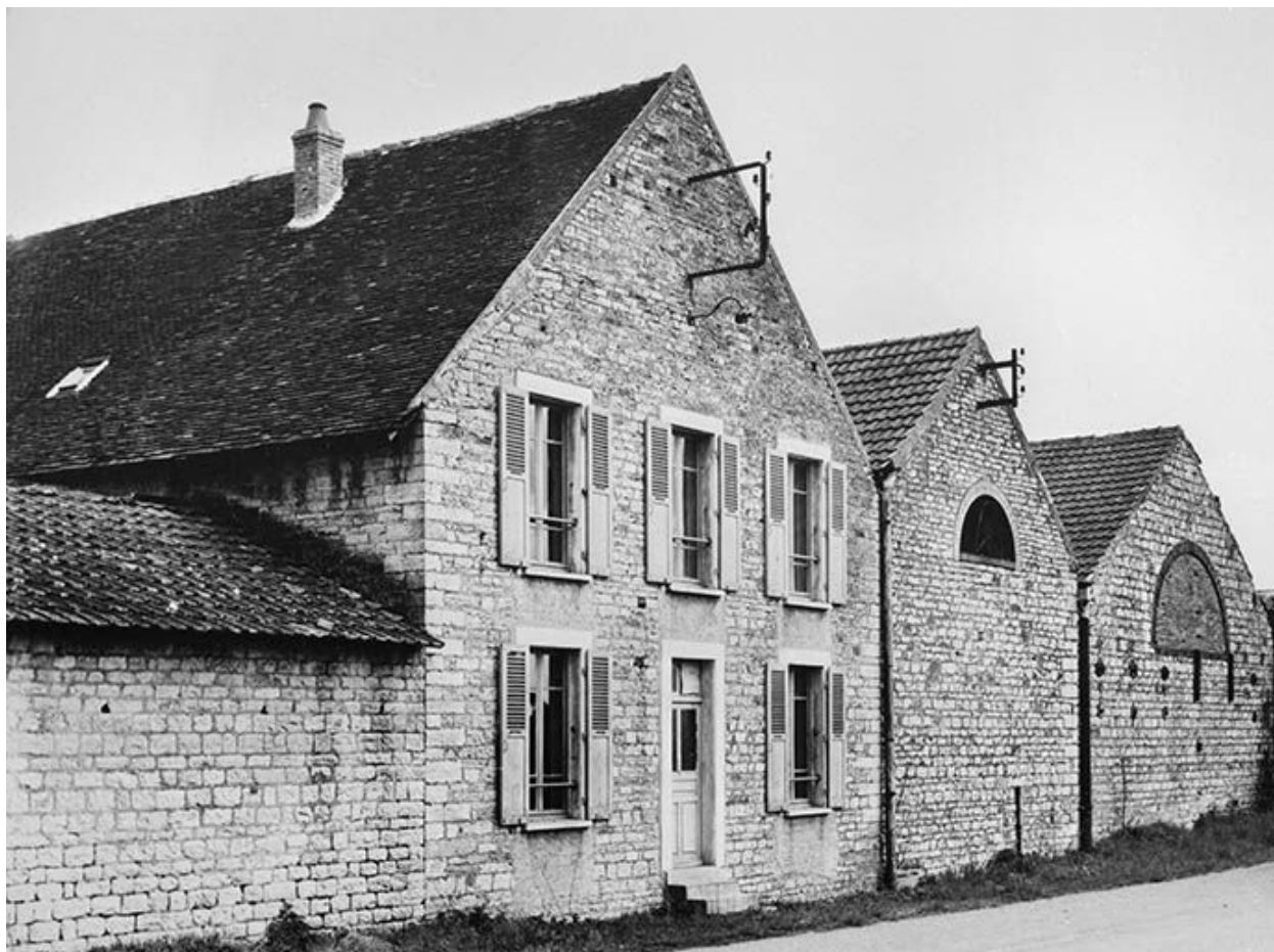
Façade antérieure du bâtiment (J).
