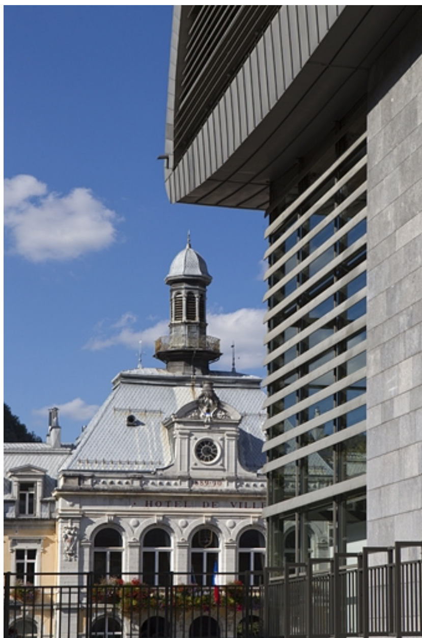
Façade latérale droite : détail.
