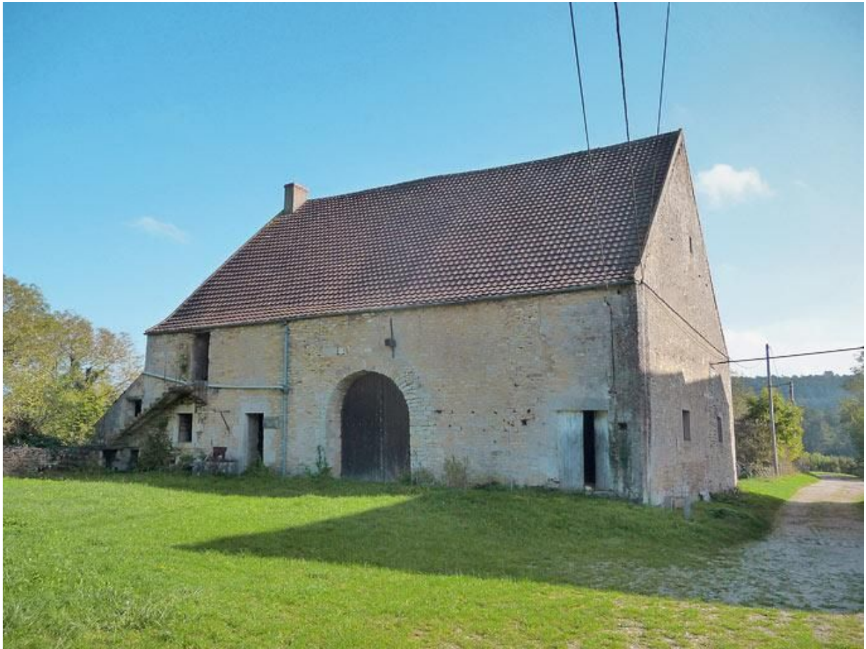
Façade de la grange.
