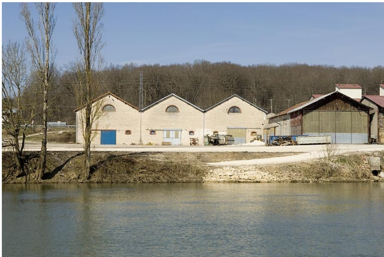
Atelier de fabrication depuis le sud-est.
