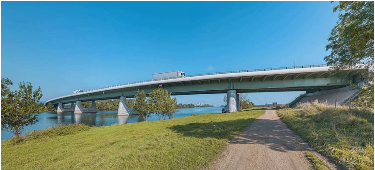
Le pont de l'autoroute A406, vu d'aval, depuis le chemin de halage rive gauche.
