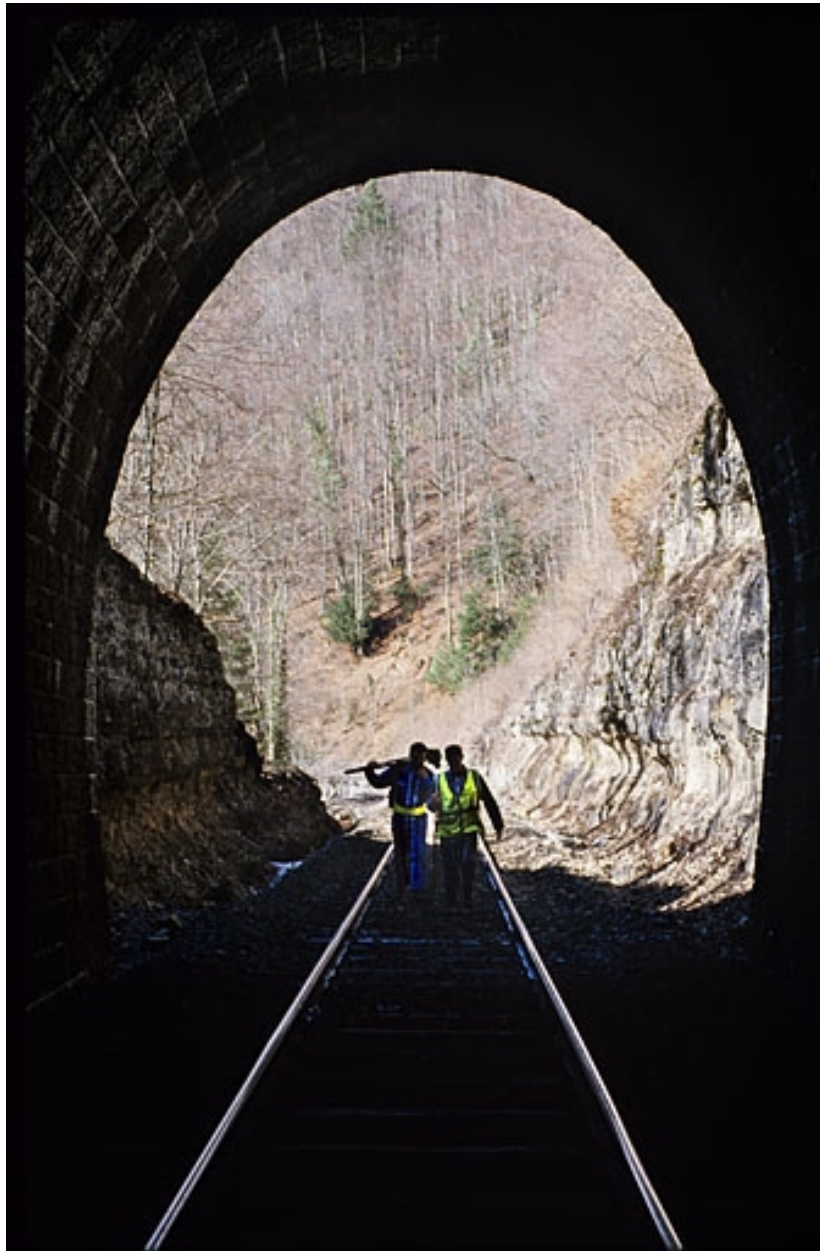
Tunnel des Bataillards : tête côté La Cluse (ouest), depuis l'intérieur.
