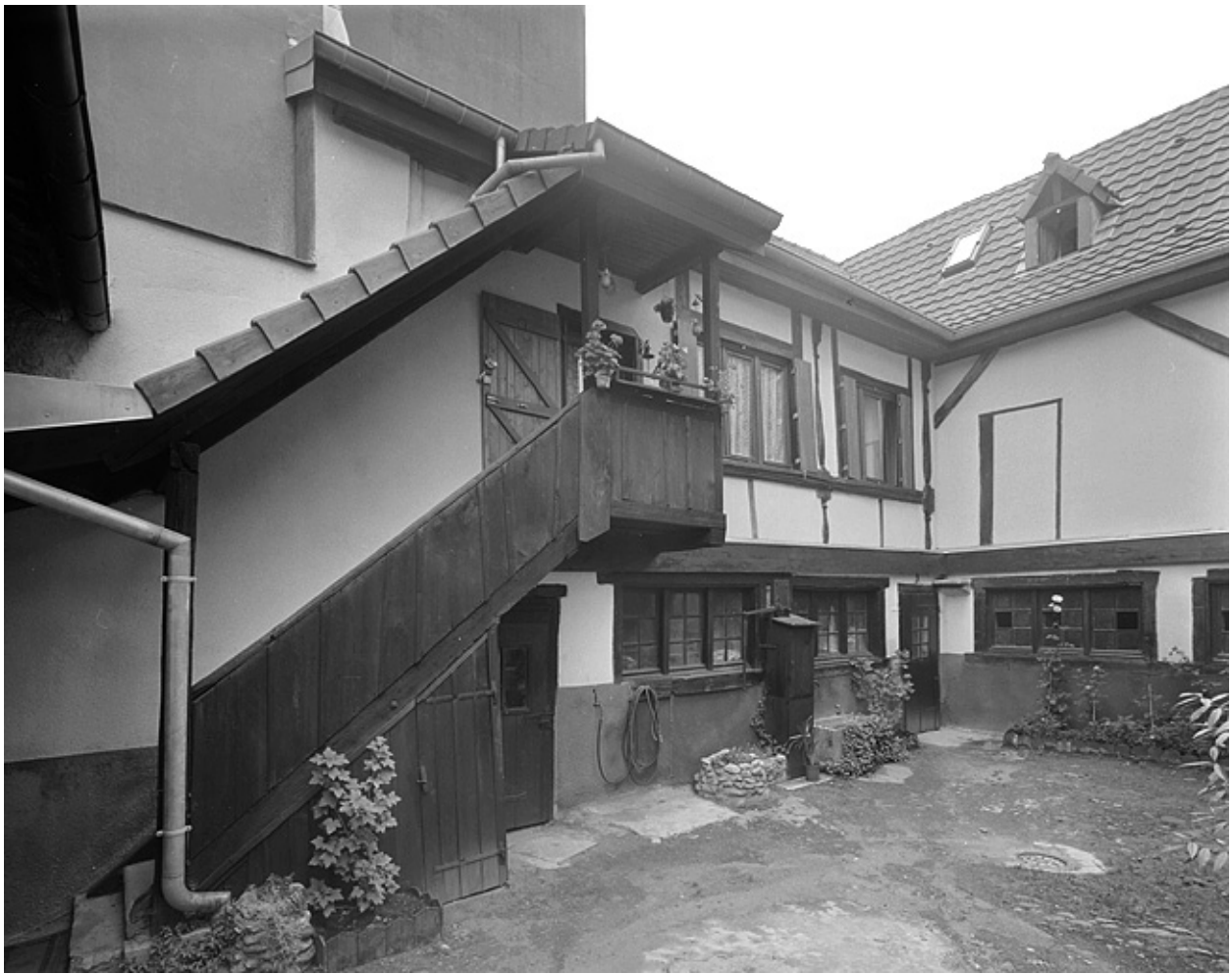
Façade arrière du corps de bâtiment du 18e siècle et galerie en retour. La galerie était ouverte à l'origine et les colonnes fortement galbées qui la soutenaient se voient encore.
